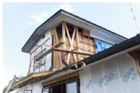
耐震改修の状況
